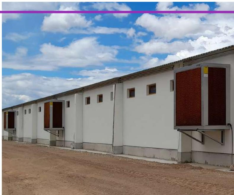
El sistema se basa en el enfriamiento evaporativo por caída de agua sobre un panel de celulosa, situado en la ventana, por el que pasa el aire. El proceso provoca la evaporación del agua, aumentando la humedad relativa y disminuyendo de esta manera la temperatura.
